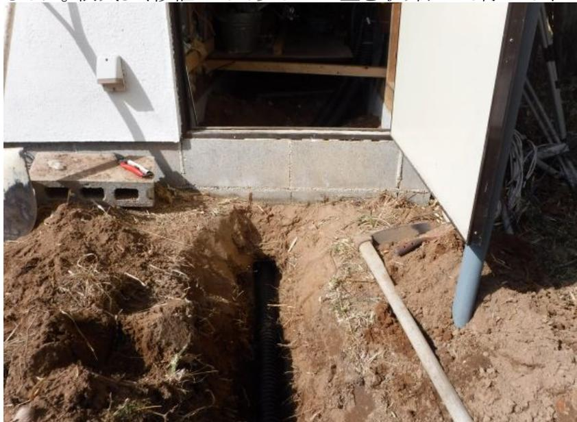
溝を掘る時に、既設の埋管を傷つけないように注意して作業したつもりだったのですが、鋭利なスコップの刃先で、穴を明けてしまった箇所が3カ所あります。水道管と違って、エフレックス管は軽いだけ肉厚が薄くて、強度はありません。放置するのは忍びないので、応急処置として、シリコンのコーキング材を適当に塗っておきました。
