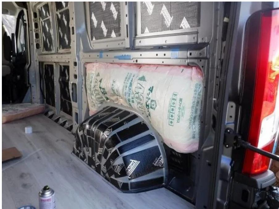
樹脂製の袋に入ったグラスワールを鉄板に貼り付けるために、3Mのスプレー糊99を使用しました。恒久的な効果は不明ですが、内張りを固定する迄の仮付けには役立ちました。グラスワールは「チクチク」するよ！というYoutubeを見ていたので、鍔で切断した時には、断面を透明のガムテープで覆うなどの処理をしました。鍔で切断する時には、文字が印刷されていない無地の方を上に向けると上手く切れました。
