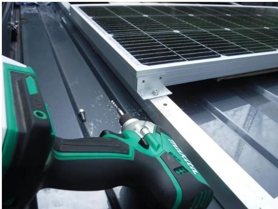
現物合わせで、ソーラーパネルのフレームにネジを切るために、取り付ける順番を工夫したつもりですが、結局、付けたり外したりして結構手間が掛かりました。最初に3枚のパネルの両側のパネルのフレームにネジを切り、それらをレールから取り外して、最後に真ん中のパネルのフレームにネジを切りました。
