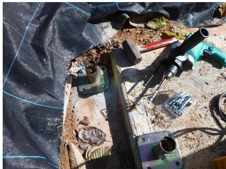
DUCATO の駐車場に屋根を取付ける計画を実行に移し始めました。駐車場にコンクリートを打ち込む時に、アンカーを用意しておけば良かったのですが、そこまでは手が回りませんでしたので、コンクリートの床面に後付けでアンカーボルトを打ち込むことにしました。
