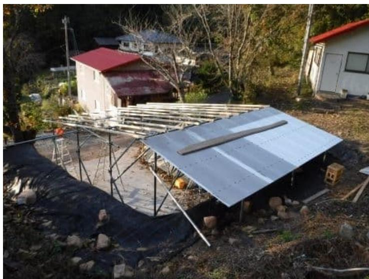
屋根を葺くために使ったガルバ波板は、コンテナハウスの遮熱のために屋根と西向きの壁に貼っていたものです。波板ビスを使ってガルバ波板を取り付けていたので、簡単に取り外して、波板ビスもガルバ板も再利用できました。
