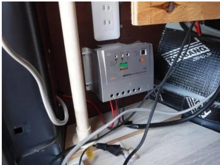
しかし、DUCATO には 100W のパネルを 3 直列にして、12V の補水型鉛蓄電池に充電しているので、10A の充電電流では足りません。そんな計算もしないまま 1 シーズン使いましたが、やはり無理がありました。ソーラーパネルを 300W にしたのだから消費電力が 40W の冷蔵庫は貯えるだろうと考えていたのですが、ソーラーの充電電流だけでは足りず、夜間はポタ電から給電していました。このチャージコントローラは 2010 年頃購入したもので、リチウム電池には対応していないため仕方なく鉛蓄電池を使っていました。
