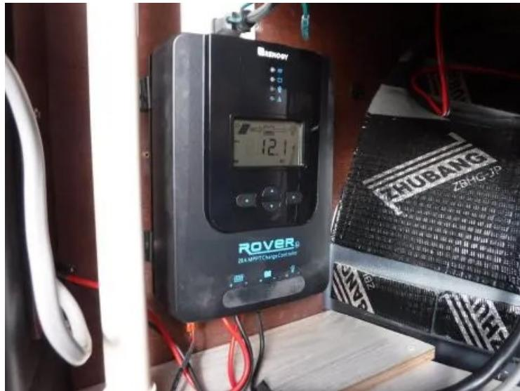
今回購入したのは Renogy の 20A のものです。勿論リチウム電池にも対応しています。これなら、12V 系でも 280Wmax までいけるので、300W のパネルの能力をほぼカバーできる筈です。今は鉛蓄電池を使用していますが、近日中にリチウム電池に交換する予定です。どっちみち、300W のパネルではせいぜい 250W 位の発電能力しかないのでしょうから、チャージコントローラの容量不足ということはないでしょう。それに、充電電流の大きなチャージコントローラでリチウム電池に充電すると発熱や性能劣化の心配があるので、リチウム電池の推奨充電電流に適合するモノを選定するのが良いと思うです。大は小を兼ねるということもあるでしょうが、充電電流が大きいものは価格も高いし団体もデカいのです。ちなみに、購入したチャージコントローラは Amazon のタイムセールで 9458 円でした。
