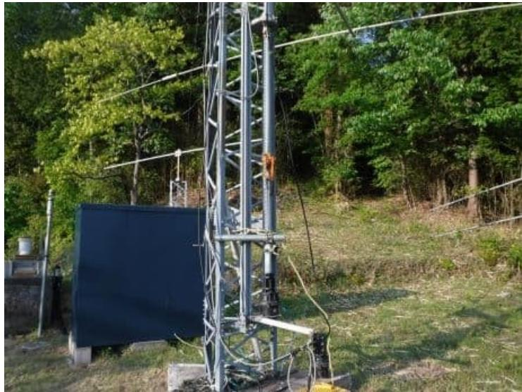
交換用のローターとして、新アンテナファームで 2m EME 用アンテナを回していた G-2800SDX を使うことにしました。同じ YAESU の製品なので、ケーブルやコネクタをそのまま流用できるので、コントローラとローター本体だけを交換するば良いのです。
